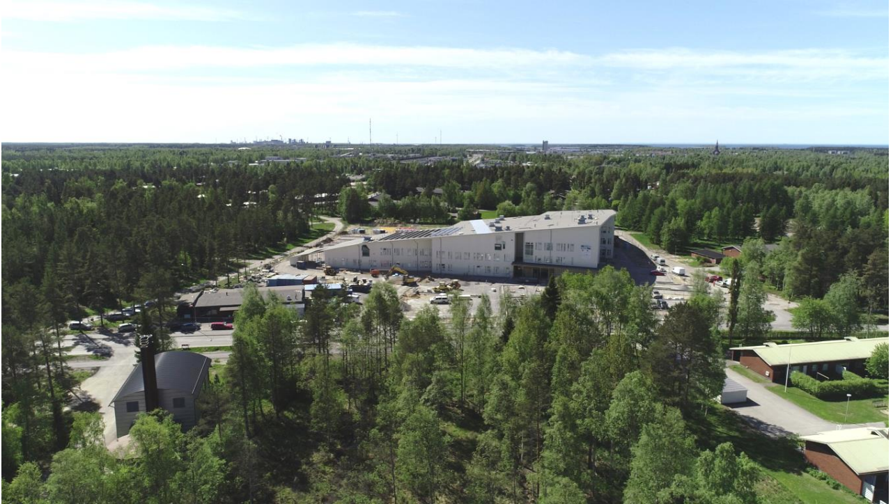
Kuva 2. Antinkankaan monitoimitalon rakennustyömaa (Raahen kaupunki, 2018b).
