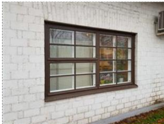
Piirteiltään vaatimattomassa rakennuksessa omaleimaisina yksityiskohtina erottuvat vaihteleva tiililimitys ja siropuiteiset ikkunat. (Kuva: Kaisa Mäkinie mi 2018)
