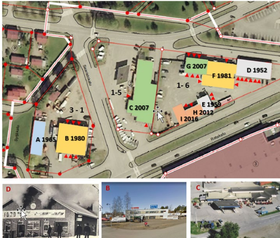
Kuva 7: Kiinteistön 3 -1 asuinrakennus (A) on vuodelta 1965 ja ajoneuvojen huoltorakennus (B) vuodelta 1980. Kiinteistön rakennukset ovat alkuperäisessä asussa. Kiinteistö on pääosin tavarankuljetustoiminnan käytössä.
