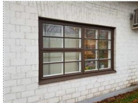
Piirteiltään vaatimattomassa rakennuksessa omaleimaisina yksityiskohtina erottuvat vaihteleva tiililimitys ja siropuitteiset ikkunat. (Kuva: Kaisa Mäkinieni 2018)
