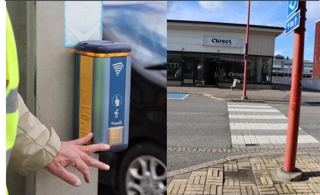
Kuva 13. Kohokuvio puuttuu napista.
