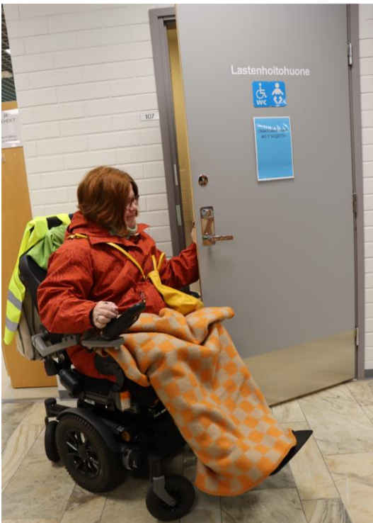
Kuva 5. Esteettömän WC:n ovesta ovipumppu, joka tekee ovesta raskaan avata.
