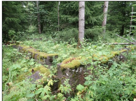
Kuva 10. Perustuksen länsikulma kuvattuna itään.
