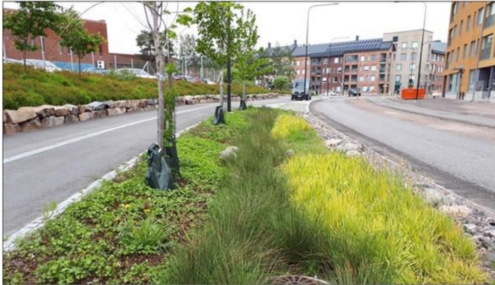
Kuva 11. Esimerkki biosuodatusrakenteesta (© Ramboll)
