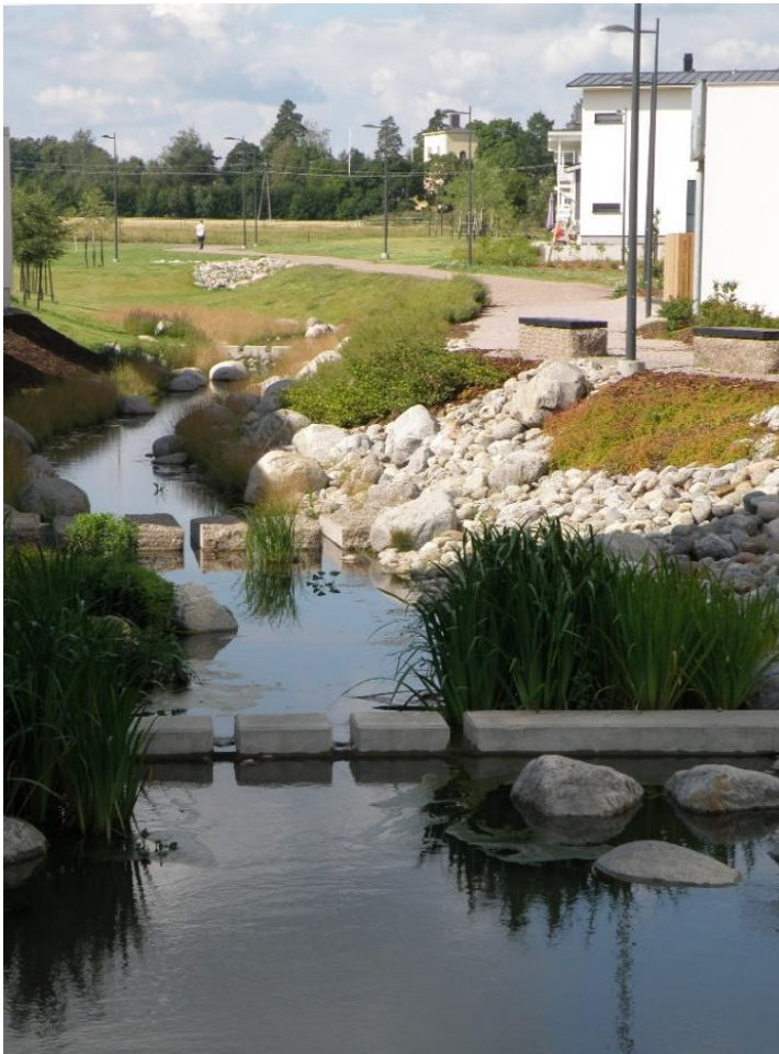
Kuva 8. Mutkitteluviivytysuoma, jossa virtaamaa on hidastettu kasvillisuudella sekä pohjapadoilla. (© Ramboll 2012)
