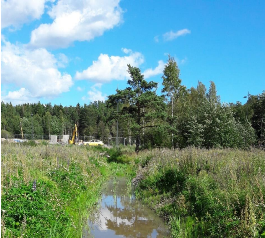
Kuva 7. Suoraviivainen viivytysoja, jossa virtaamaa on hidastettu kasvillisuudella. (© Ramboll/Marjo Valtanen)
