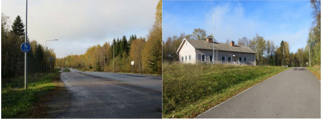
Kuva 14 Suunnittelualue rajautuu pohjoisessa Pajuniityntiehen, josta erkanee suunnittelualueelle johtava Nikolantie. Nikolantien varteen sijoittuu Palon vanhan keskuskoulun pihapiiri sekä muutama omakotitalo.
