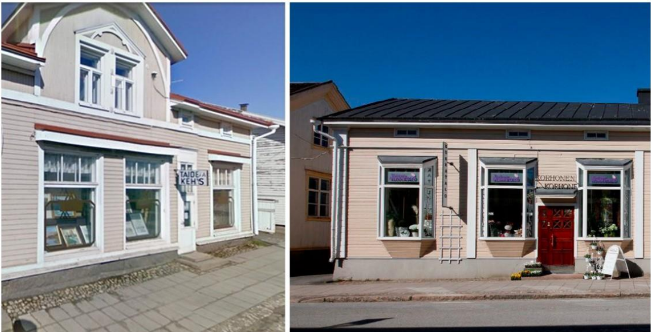
Kuva 10. Vasemmalla: Kauppakadulla vanhojen liiketilojen suuret ikkunat avautuvat katutilaan. Oikealla: Katujulkisivu Kirkkokadulta, Kuvat: Minttu Kervinen, 2020
