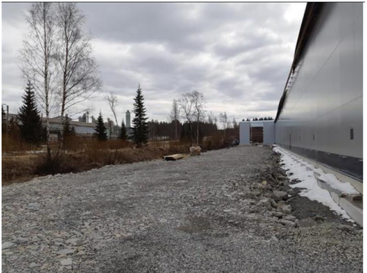
Kuva 1-6. Valokuva alueelle rakentuvan hallin kulmalta kaava-alueen pohjoisosasta etelään, Rautaruukintien suuntaisesti. Kuva: Raahen kaupunki.
