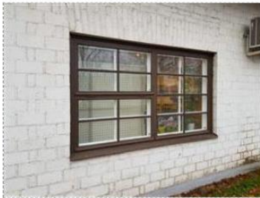
Piirteitään vaatimattomassa rakennuksessa omaleimaisina yksityiskohtina erottuvat vaihteleva tiililimitys ja siropuitteiset ikkunat. (Kuva: Kaisa Mäkinie mi 2018)
