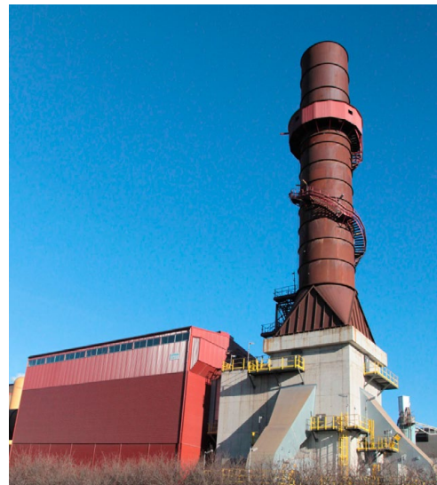
Kuva 4. Terästehtaan sulaton pölynpoistorakennus (©SSAB Europe Oy)
