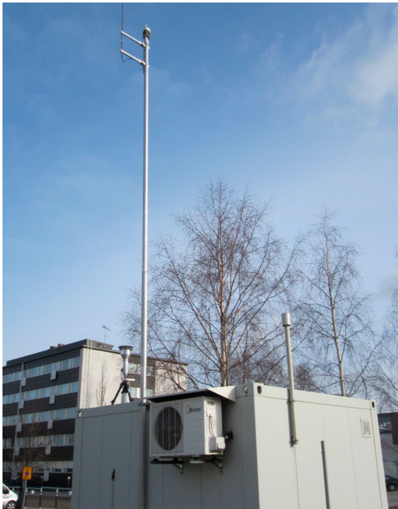
Kuva 2. Keskustan mittauspiste. Katolla NOx ja PM10 näytteenottopäät, sekä sääsäseman pitempi salko.
