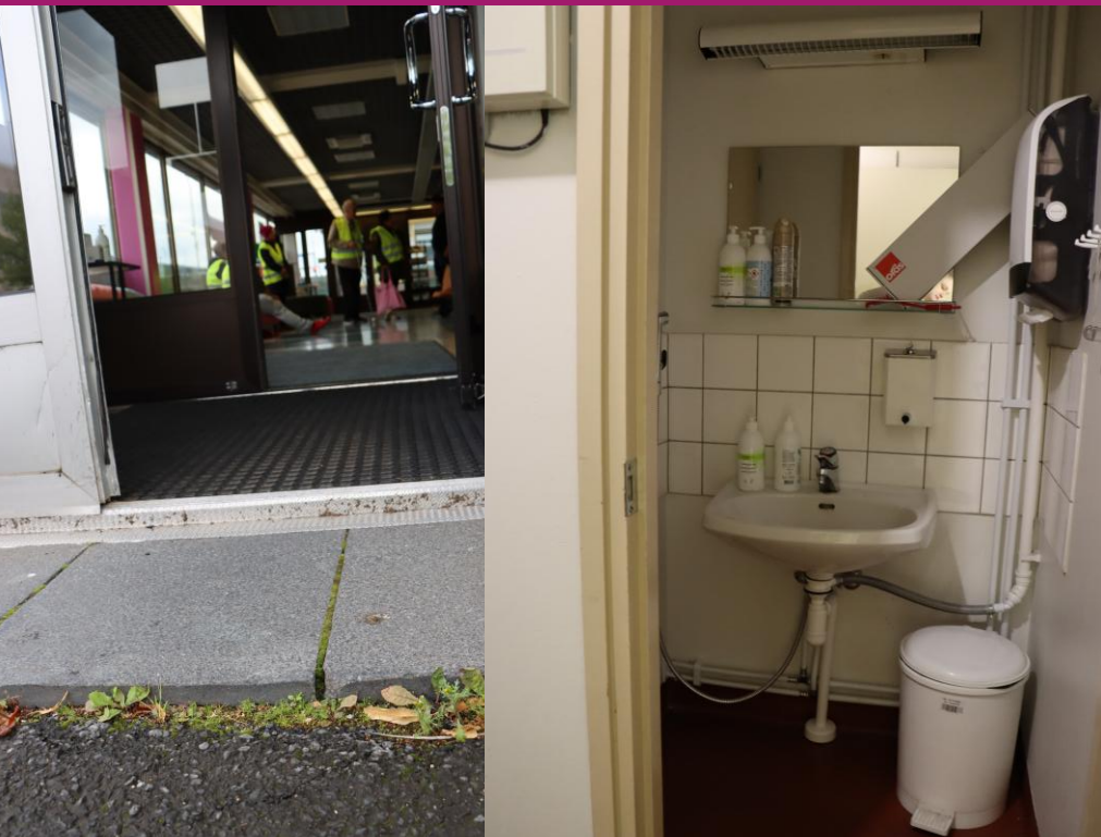
Kuvat 16, 17. Korkea kynnyks ja pieni wc.
