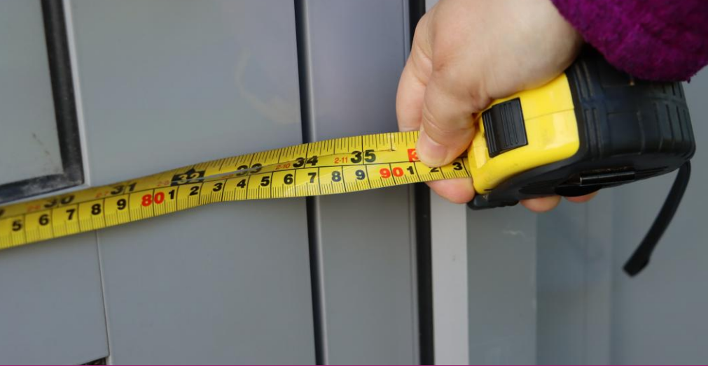
Kuva 15. Liian kapea ovi pyörätuolille.
