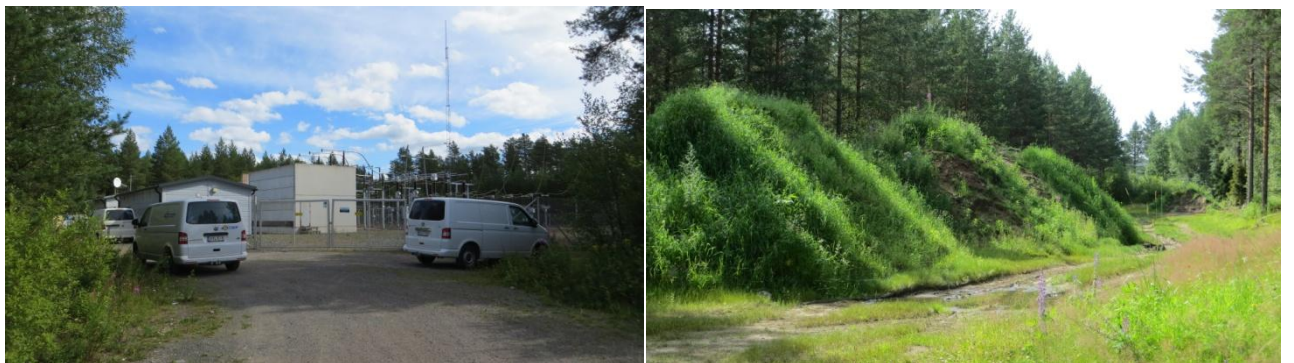
Raahen Energia Oy:n ja Elenia Oy:n omistamien sähköasemien alue. Rakentumattomalle alueelle varastoitua maa-ainesta.
