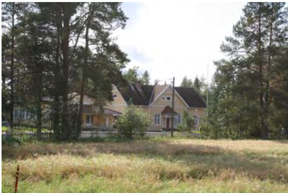
Kopsan käytöstä poistettu koulurakennus edustaa vanhaa rakennuskantaa ja on kulttuurihistoriallinen kohde.
