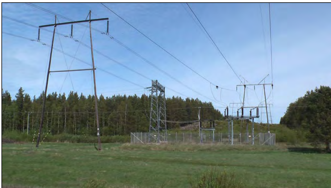
Voimajohto kantatien 88 kohdalla
