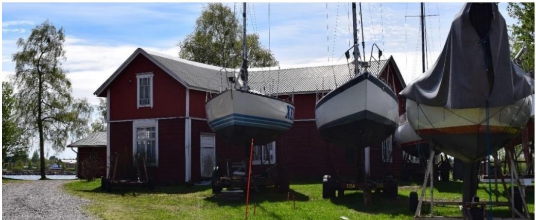
Kuva 53. Pursimajan pihanpuoli, julkisivu pohjoiseen.
