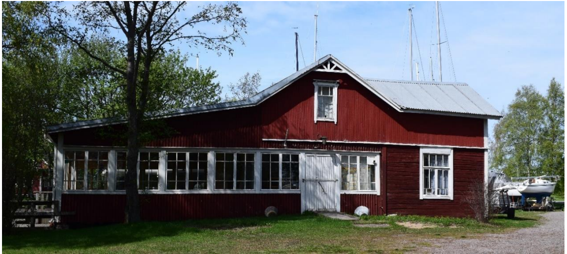
Kuva 52. Pursimajan kaakon julkisivu.
