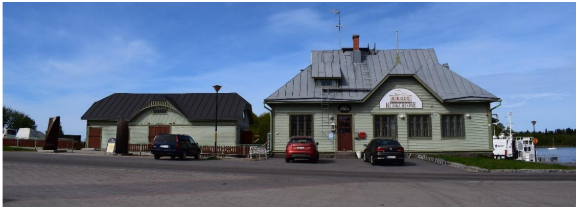
Kuva 12. Ruiskuhuone ja Pruutta.
