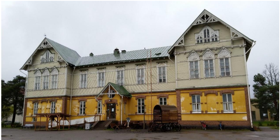
Kuva 17. Raahen seminaarin harjoituskoulurakennus (rakennus 7A).
