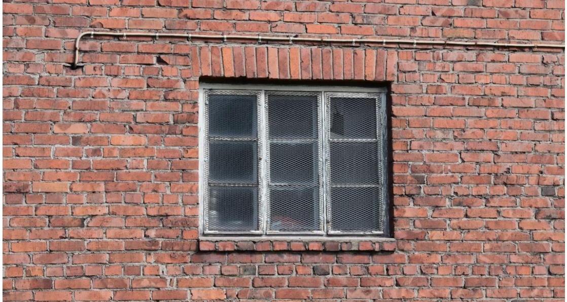
Kuva 6. Vanhan paloaseman tiililadontaa.
