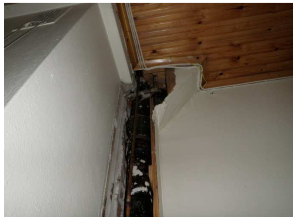
Kuva 6. Vesi- ja viemäriputket ovat käyttökänsä lopussa
