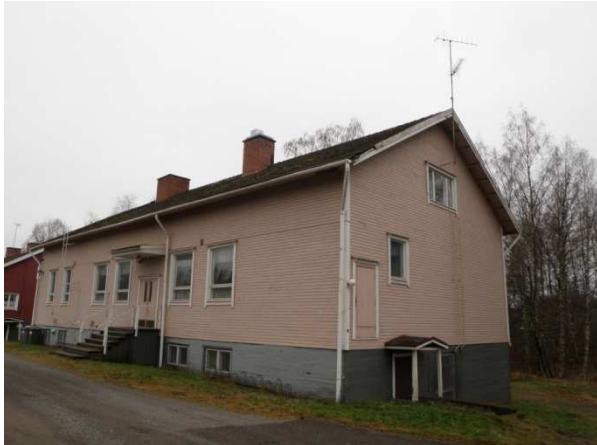
Kuva 1. Yleiskuva rakennuksen julkisivusta
