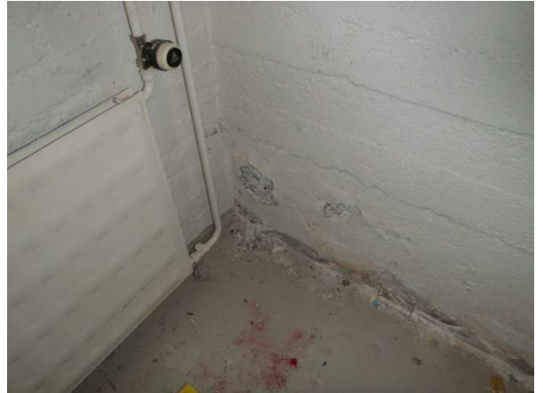
Kuva 2. Ulkopuolisen kosteusrasituksen aiheuttamia vaurioita kellarin seinien alaosissa
