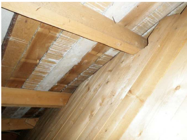
Kuva 5. Toisen kerroksen vino yläpohjaosuus tuulettuu heikosti
