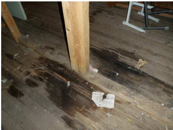
Kuva 3. Vesikaton vuotokohta kattoluukun kohdalla
