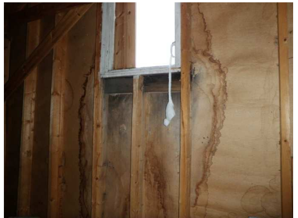
Kuva 4. Julkisivun vesivuoto ullakon ikkunan ympärillä
