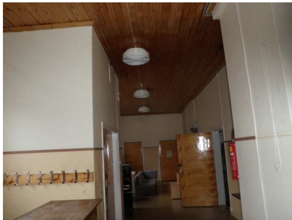
Kuva 9. Yleiskuva 1. kerroksen käytävältä
