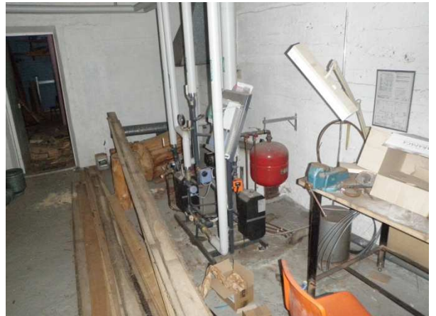
Kuva 8. Kaukolämmön alajakokeskus on vuodelta 2004
