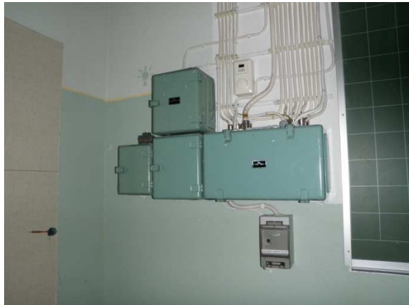
Kuva 7. Sähköt ovat pääosin alkuperäisiä, joitakin lisäyksiä on tehty
